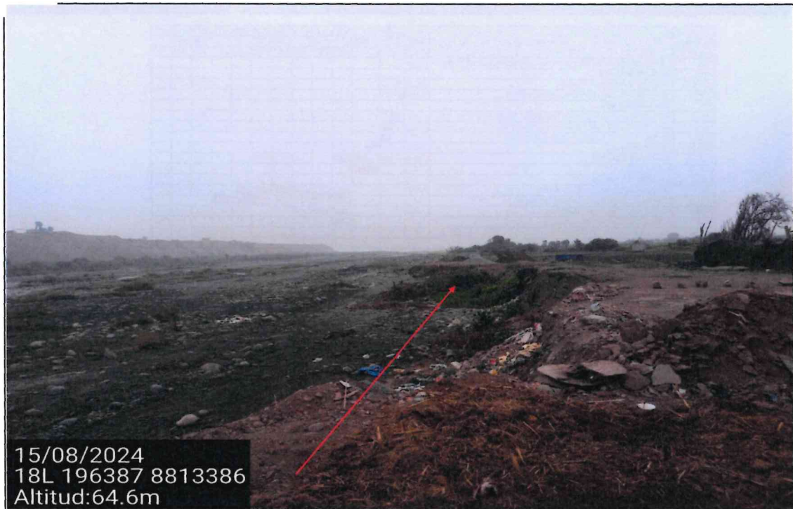
FIGURA N°02: MARGEN DERECHA DEL RIO PATIVILCA EROSIONADO Y CAUCE COLMATADO, DESPROTEGIDO ANTE CRECIDAS DEL RIO EN EL SECTOR PUENTE BOLIVAR, DISTRITO DE PATIVILCA, PROVINCIA DE BARRANCA - DEPARTAMENTO DE LIMA.
